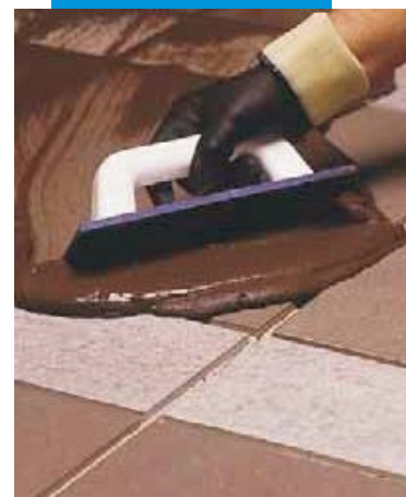
Spárování dlažby Ultracolorom Plus pomocí gumového hladítka
