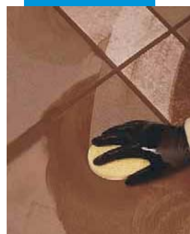
Čištění a konečná úprava spár houbou
