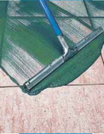
Spárování dlažby Ultracolem Plus gumovou spárovací stěrkou s násadou
