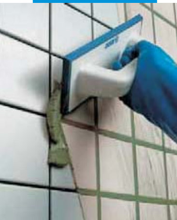
Spárování obkladů Ultracolem Plus spárovací gumou
