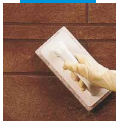
Čištění spár Scotch-Brite® (částečné zatvrdlý tmel)
