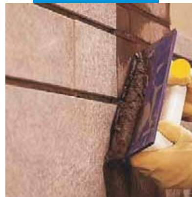
Spárování obkladů stěn Ultracolorom Plus gumovou stěrkou
