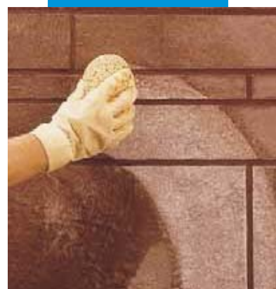
Čištění a konečná úprava spár houbou
