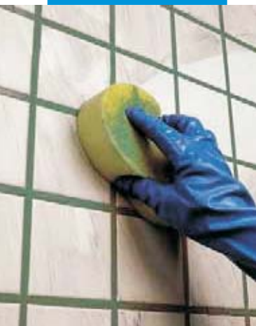
Konečná úprava obkladů pomocí houby
