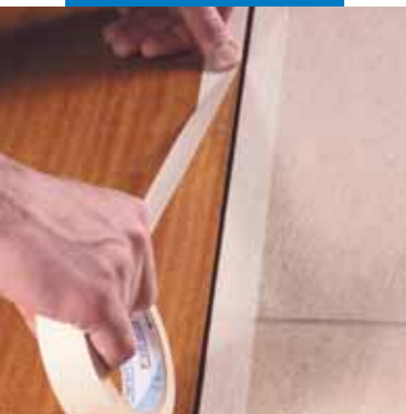
Príprava ochranej vrstvy pred vyplnením škáry
