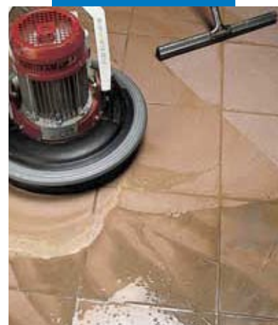
Konečná úprava glazované dlažby pomocí elektrického spárovacího a čistícího stroje
