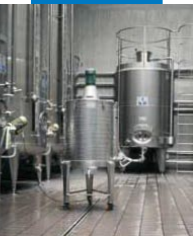
Ukázka spárování ve vinném sklepě
