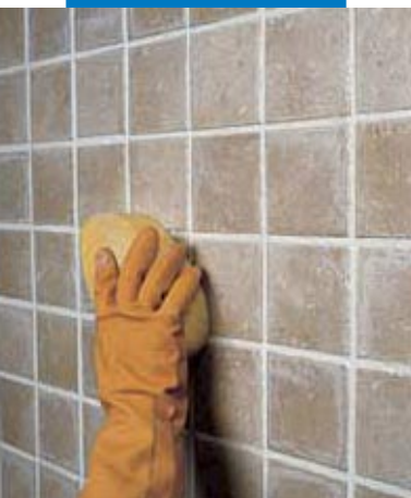
Konečná úprava jedenkrát pálených obkladů pomocí houby
