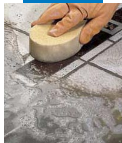
Konečná úprava keramické dlažby s vloženými dřevěnými prvky pomocí houby
