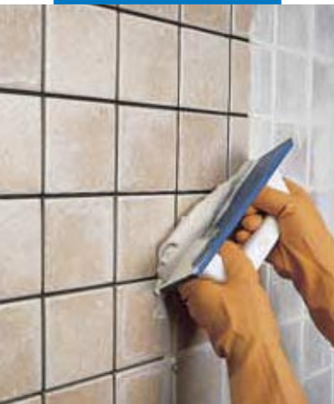
Spárování obkladu ze slinutých dlaždic pomocí gumové stěrky
